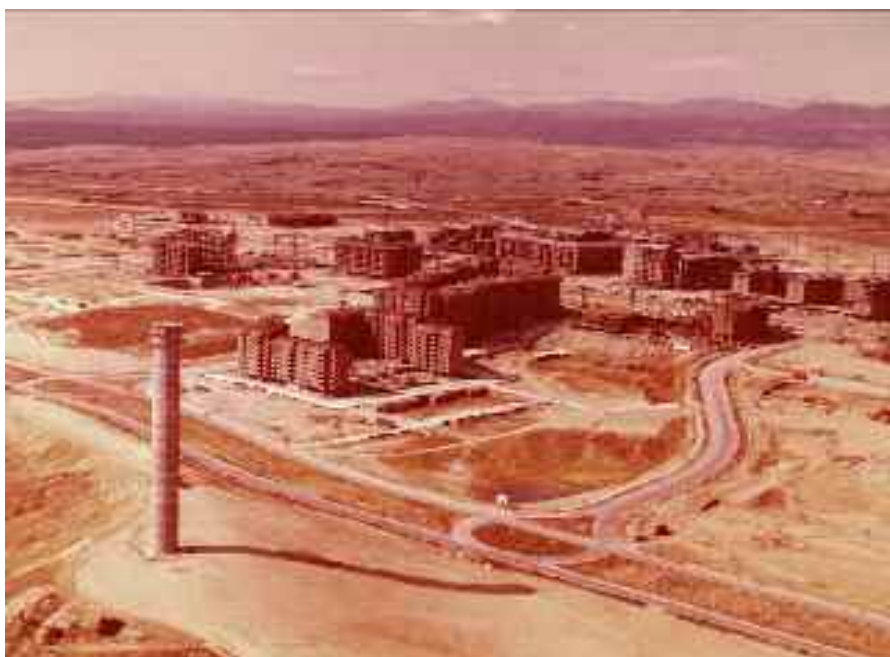
“Actuación Urbanística de Tres Cantos (Madrid) en suelo público; abajo, en proceso de urbanización y edificación; arriba, promociones de viviendas cooperativas terminadas”
